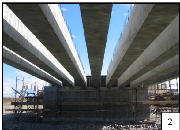
Figur 1. Platsbyggda stöden, Figur 2. Längsgående prefabricerade balkar på stöden Figur 3. Montering av formplattor, Figur 4. Färdig bro över Skenaån (Skänninge)
