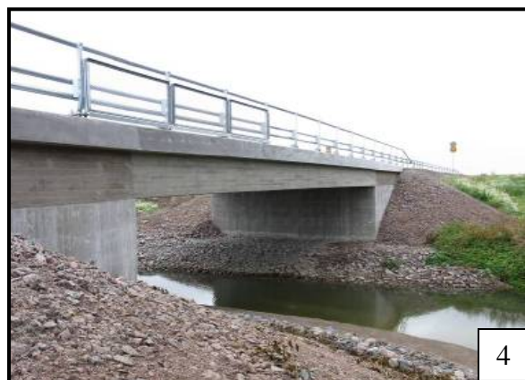
Figur 1. Platsbyggda stöden, Figur 2. Längsgående prefabricerade balkar på stöden Figur 3. Montering av formplattor, Figur 4. Färdig bro över Skenaån (Skänninge)
